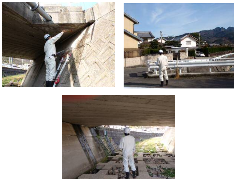
図 3.1 定期点検の様子
