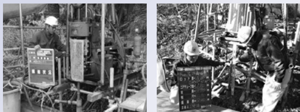
新しい処分場の地質調査の様子
