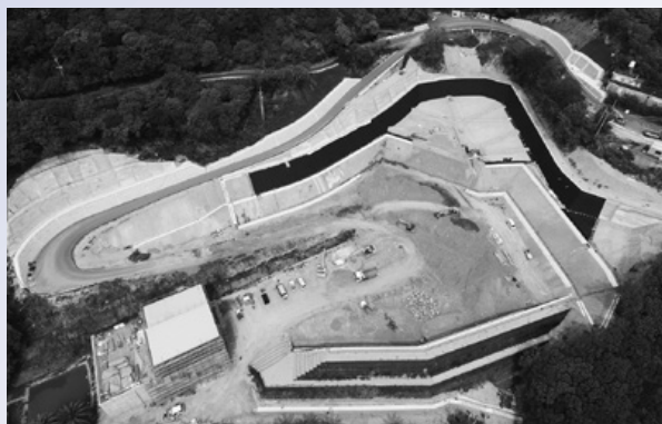
令和4年度の処理開始を目指し、新しい処分場の建設工事を進めています
