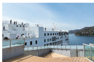
屋上 展望送迎デッキ
