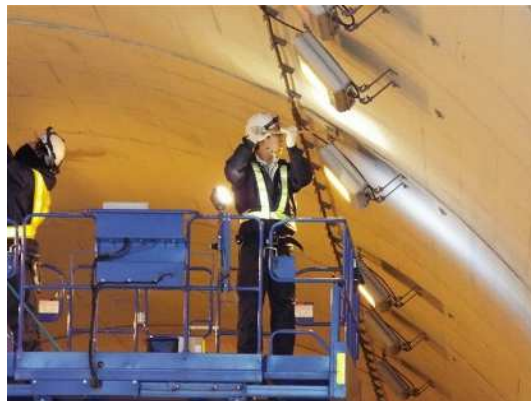
図 3.1 定期点検の様子
