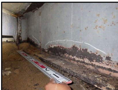
図 1.3 鋼橋の損傷状況
