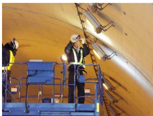
図 3.1 定期点検の様子
