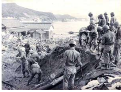
谷尻地区の状況
