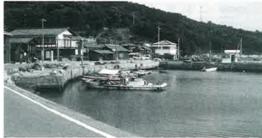
改修が望まれる田浦漁港
