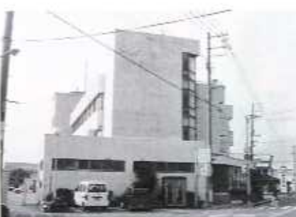
内海庁舎南館
