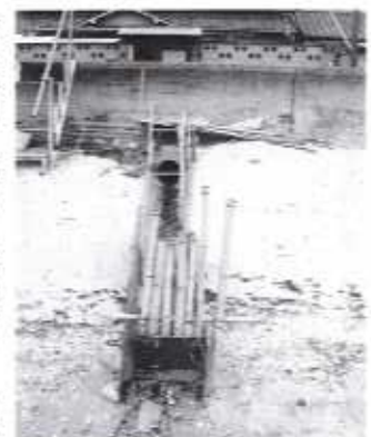
手作りの導流堤(入部)
