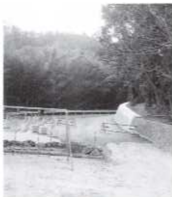
内海ダム町道付替道路(工事中)
