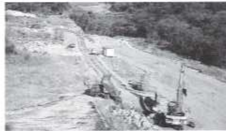
工事が進む安田～橋間の国道改築
