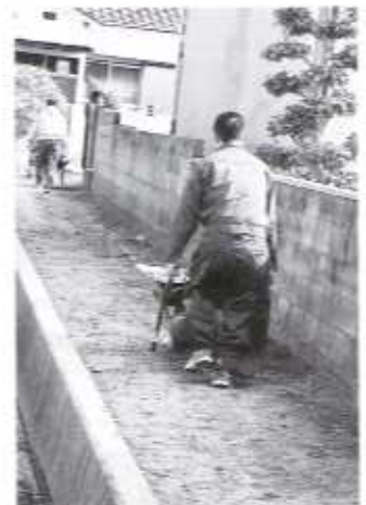
里道舗装の作業中(片城)
