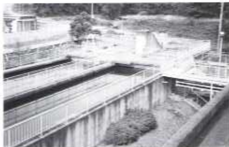
町民にきれいな水を(浄水場)
