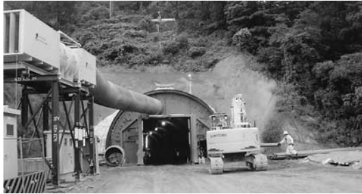
橘トンネル工事中(国道436号)
