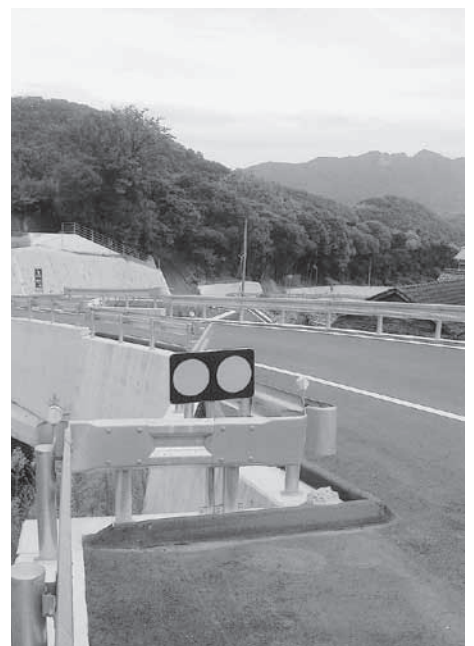
着々と進む内海ダム再開発工事（町道付替）
