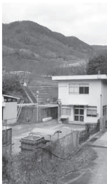
老朽化の進む中山浄水場
