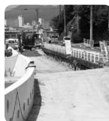
拡幅工事が進む 国道 436 号
