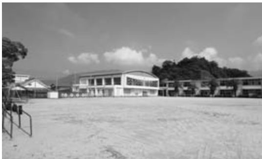
建設予定地の苗羽小学校グラウンド
