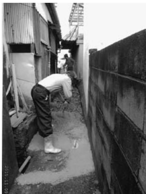
里道の舗装の様子
