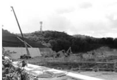
建設中の小豆島中央高校
