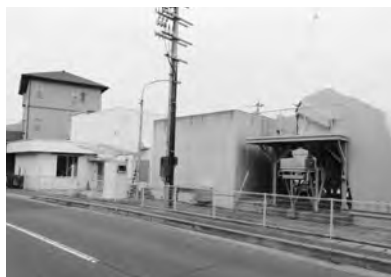
植松ポンプ場
