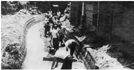
木庄川で復旧作業をする自衛隊（49災害）
