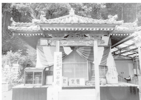
地域の力で改修した札所
