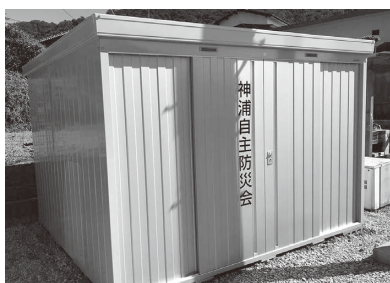
令和元年度に整備された防災備品倉庫
