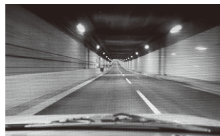
海底トンネル
