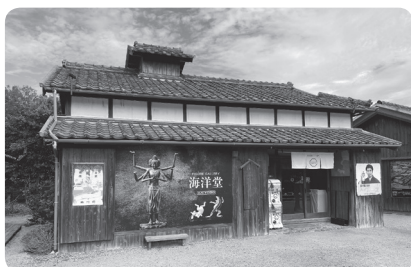
改修された施設（海洋堂アートギャラリー）
