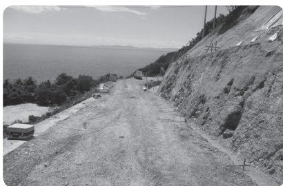
工事現場の様子
