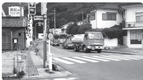
工事再開 草壁港付近
