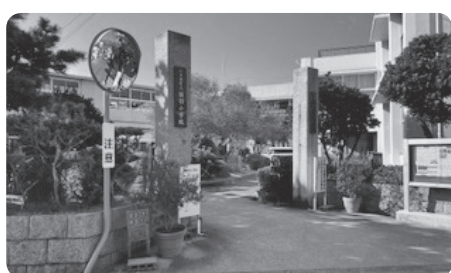
築60年経過した苗羽小学校
