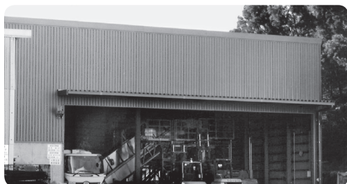
新設されたエコプラザ小豆島
