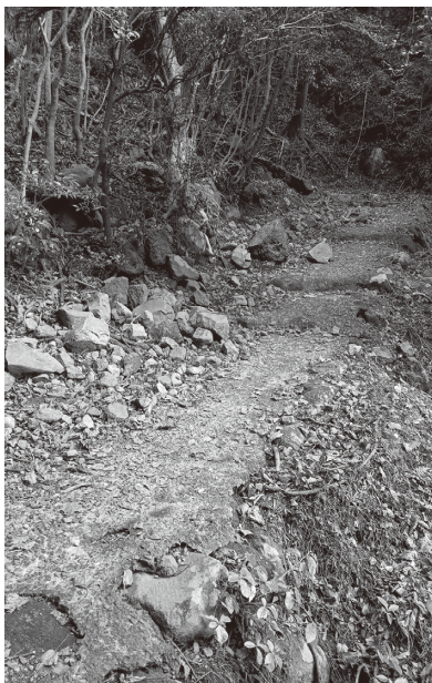
傷んだ町道 神懸線
