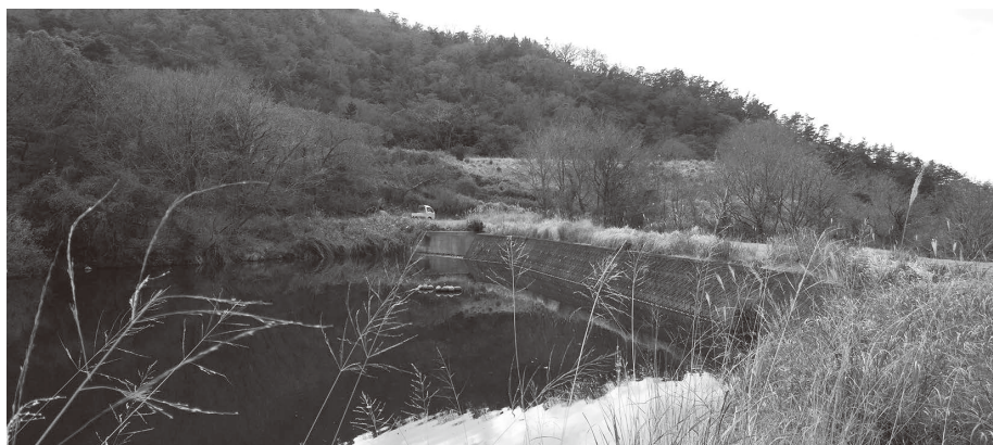
管理道の確保が懸念されるため池（上地区）
