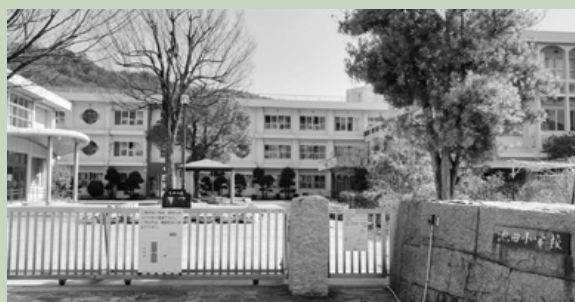
長寿命化改修工事へ（池田小学校）
