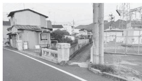
改修予定の旧片城橋
