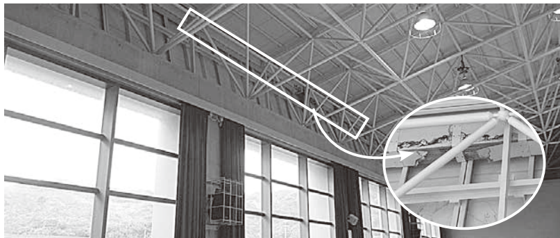
小豆島中学校の雨どい修繕箇所
