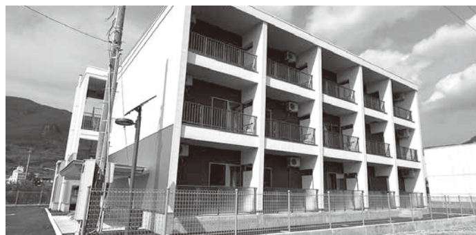
北条地区更新住宅（第1工区）
