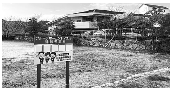
グループホーム建設予定地(土庄町湊崎)
