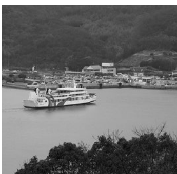
池田港再整備
