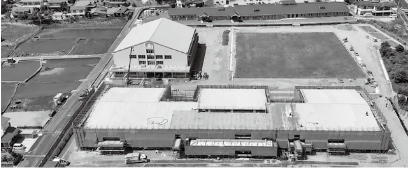
建設中の内海小学校
