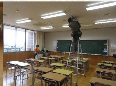
無線アクセスポイントの取付作業
