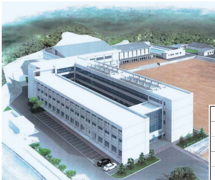
〈北西から校舎棟を望む〉
