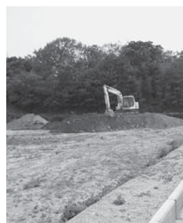
一般廃棄物埋立処分地
